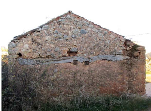
Figura 10: Viga sinuosa de enebro bajo el cargadero de un lagar. Fuentenebro (Burgos)
