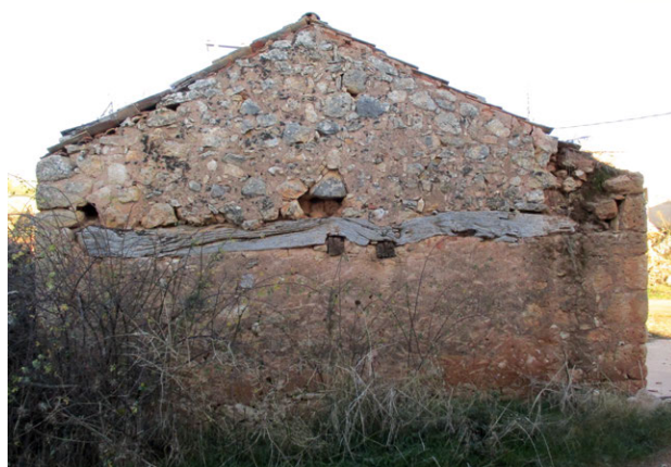
Figura 10: Viga sinuosa de enebro bajo el cargadero de un lagar. Fuentenebro (Burgos)
