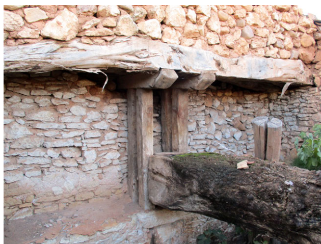
Figura 12: Vareñas y machones del cargadero de enebro. Fuentenebro (Burgos)
