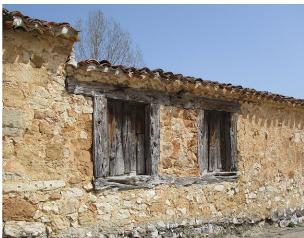
Figura 9: Recercado de portajones de descarga con enebro. Arauzo de Miel (Burgos)
