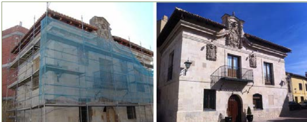
Hospedería Concejo, D.O.P. Cigales. 1) Durante la reforma (Septiembre de 2009) y 2) Tras su rehabilitación (Septiembre de 2014).
