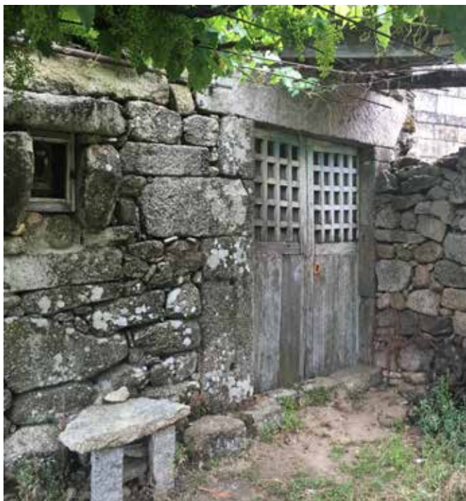
Antigua bodega de piedra
