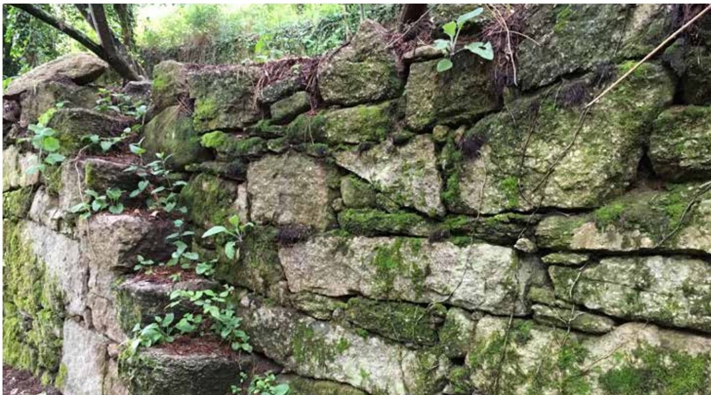
Piedras de granito en la construcción de terrazas
